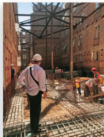
urušila, trebalo je izraditi nutarnju čeličnu konstrukciju koja bi sprezanjem zidova i zahvatima kroz prozorske otvore držala čvrstim ostatak zgrade. Nakon tako zahtjevnog zahvata i rušenja unutrašnjosti Kolegija ostala su samo tri stubišta i vanjski zidovi bez krova.
